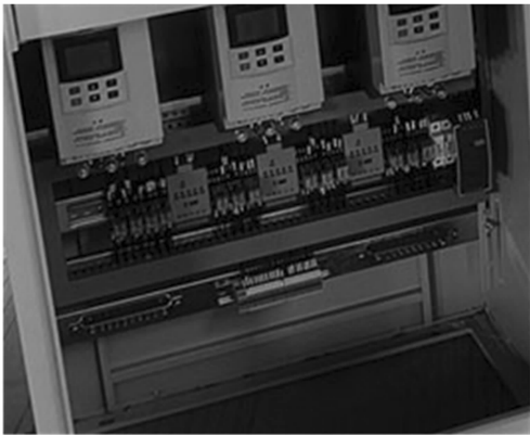
图 10 小型 PLC 元件安装实景图
