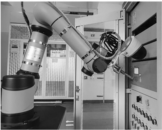
图6 带电作业机器人控制测试现场图
